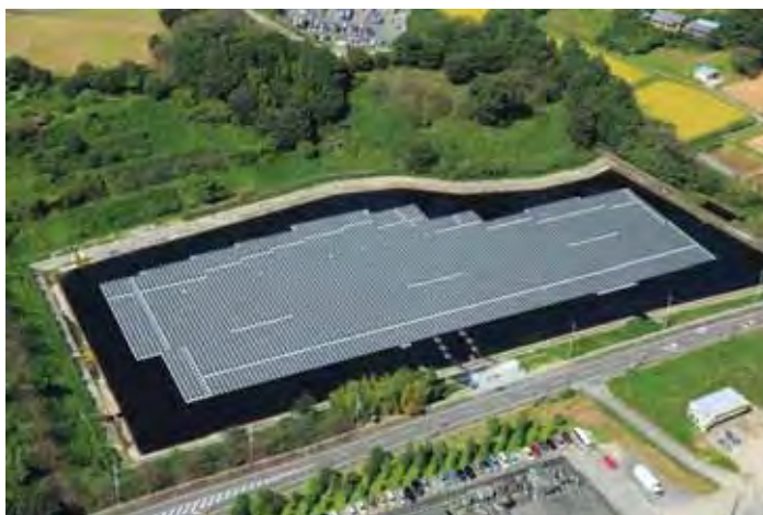
嵐山水上太陽光発電所
